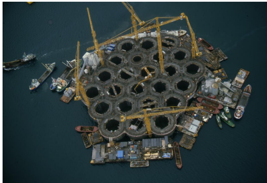
Bygging av oljeplattformen Gullfaks A. Tilhører norsk Oljemuseum, NOM-Gullfaks A-4.0-1984.6
